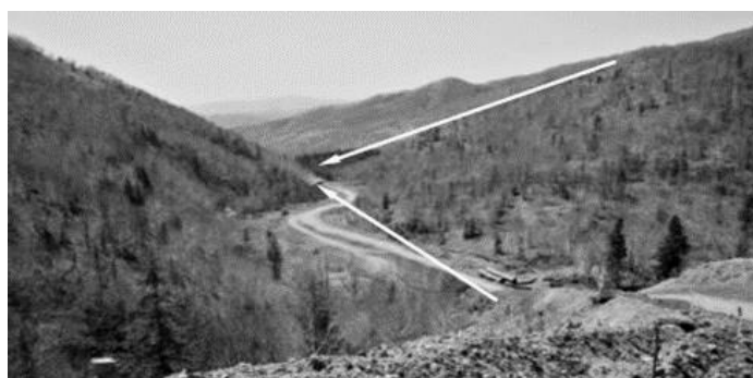
Рисунок 1 – Укладка трубопровода в селевом русле реки Пулька (Казаков, 2008)
